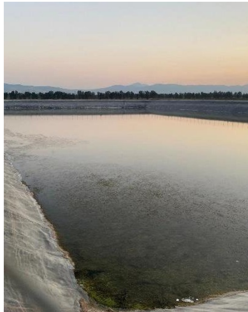
Εγκατάσταση Water Vital®, Όμιλος EL HILAL (Αλγερία)
